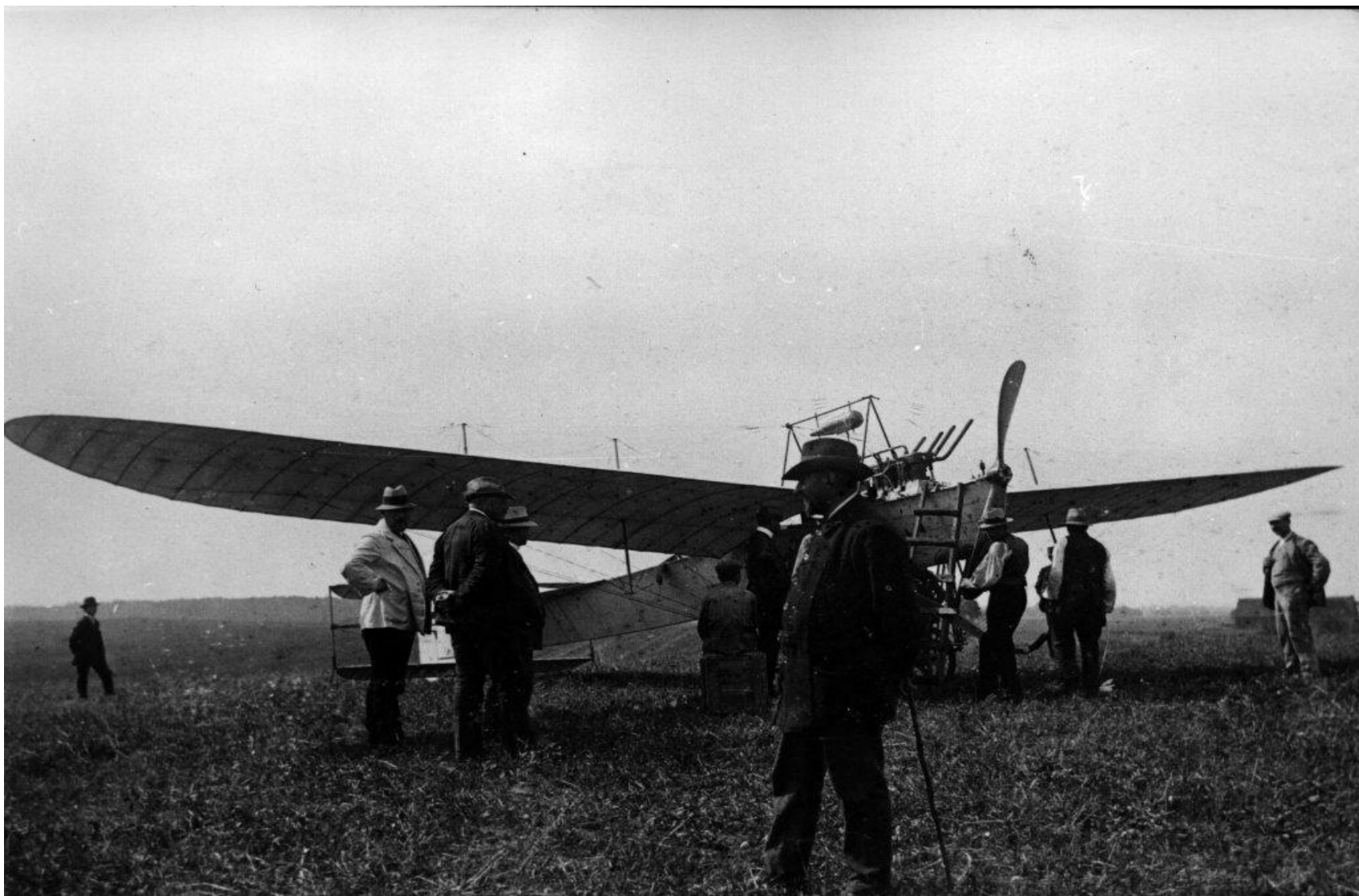
Samolot zbudowany w Reszlu, zbudowany z inicjatywy Rudolfa Festa wg rysunków (nowatorskiego projektu) inż. Bloessa z Rastemburga (Kętrzyna), mający oryginalne sterowanie, silnik o mocy 50 km ,samolot miał 10 m długości, 14 m szerokości i ważył 450 kg
